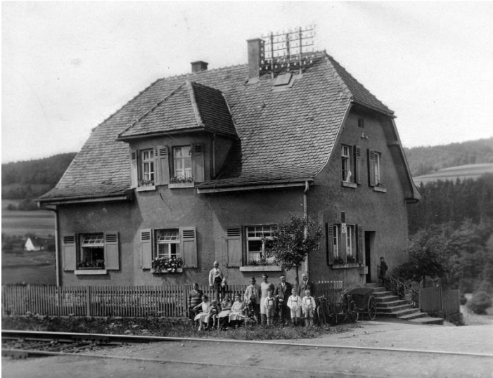
3 Ehemaliges Anwesen Brandenstein.
