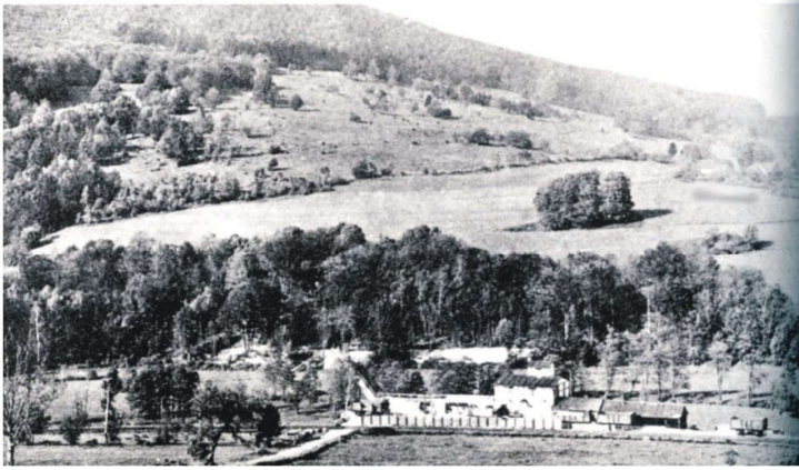
Ansicht Großer Auersberg mit Waschanlage
