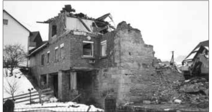
Die ortsansässige Firma Adolf Richter & Sohn übernahm die Abrissarbeiten. Das Foto zeigt die Rückseite des Mühlenanwesens, wo sich einst das Mühlrad befand. (Fotosammlung: Walter Kömpel, Oberbach)
