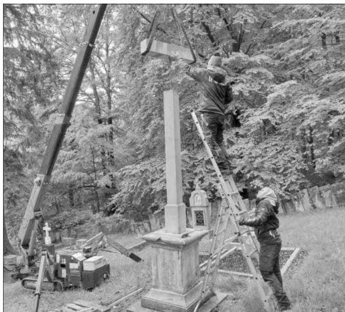
Mit dem Kran wird der Querbalken an seinen Platz gehoben, Tobias Hummel sichert ihn von der Leiter aus. Foto: Thomas Helfrich
