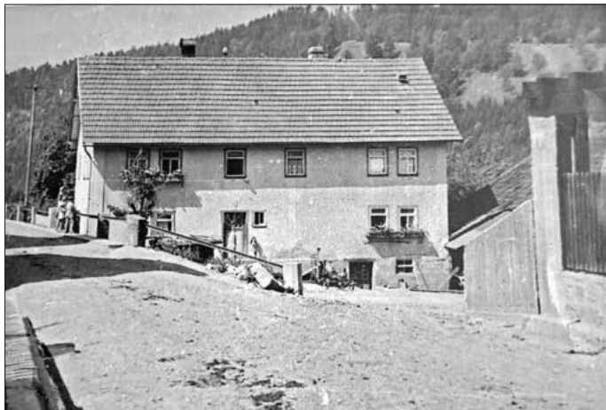
Noch vor dem Ersten Weltkrieg wurde die Mühle umgebaut. (Karl und Rita Girz, Oberbach)
