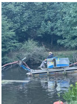
Vorbereitende Klärschlammräumung in Oberbach · Foto Daniel Kleinheinz
